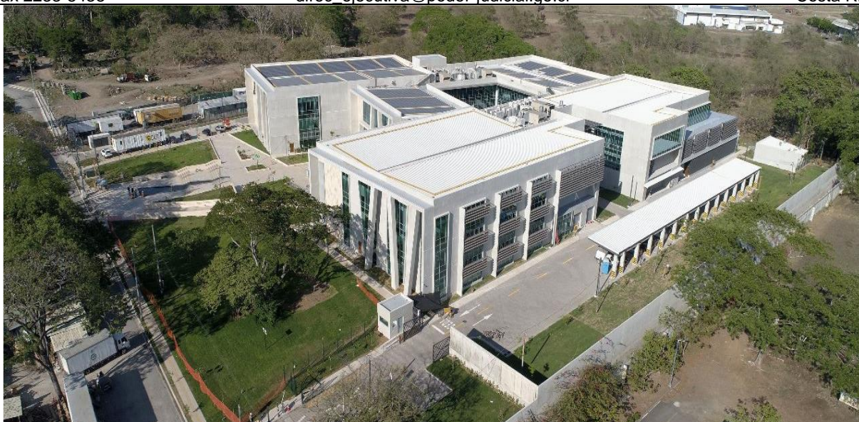
Vista avance de obras, marzo 2023
